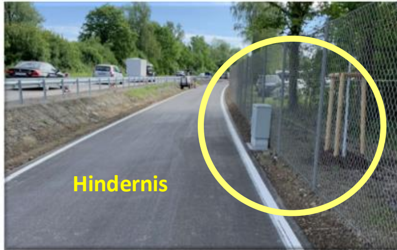
Audit: „B 31 – Ausbau Radweg Immenstaad – AS Fischbach West“ (Vor Verkehrsfreigabe)
