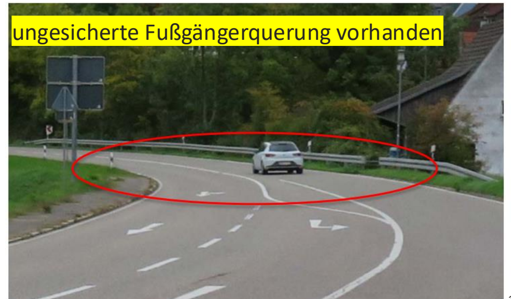
Abbildung 4: Ungesicherte Fußgängerquerung östlich des Knotenpunktes L 1045 / K 2384, Blickrichtung Osten
