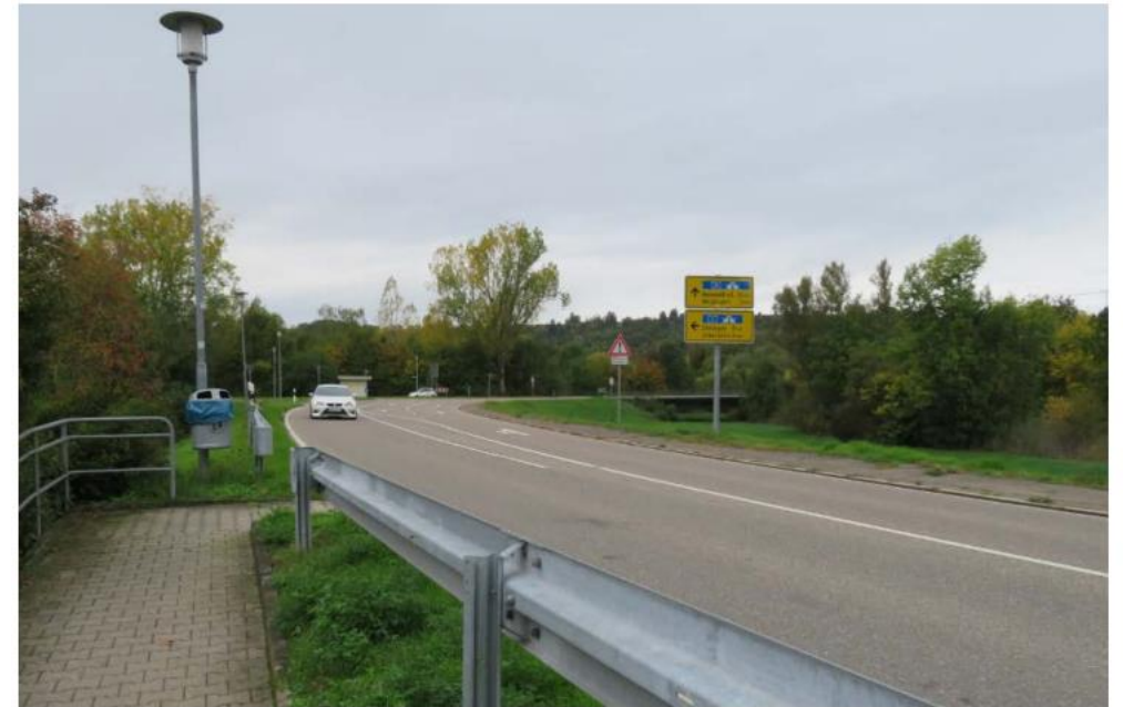
Abbildung 3: Ungesicherte Fußgängerquerung östlich des Knotenpunktes L 1045 / K 2384, Blickrichtung Westen
